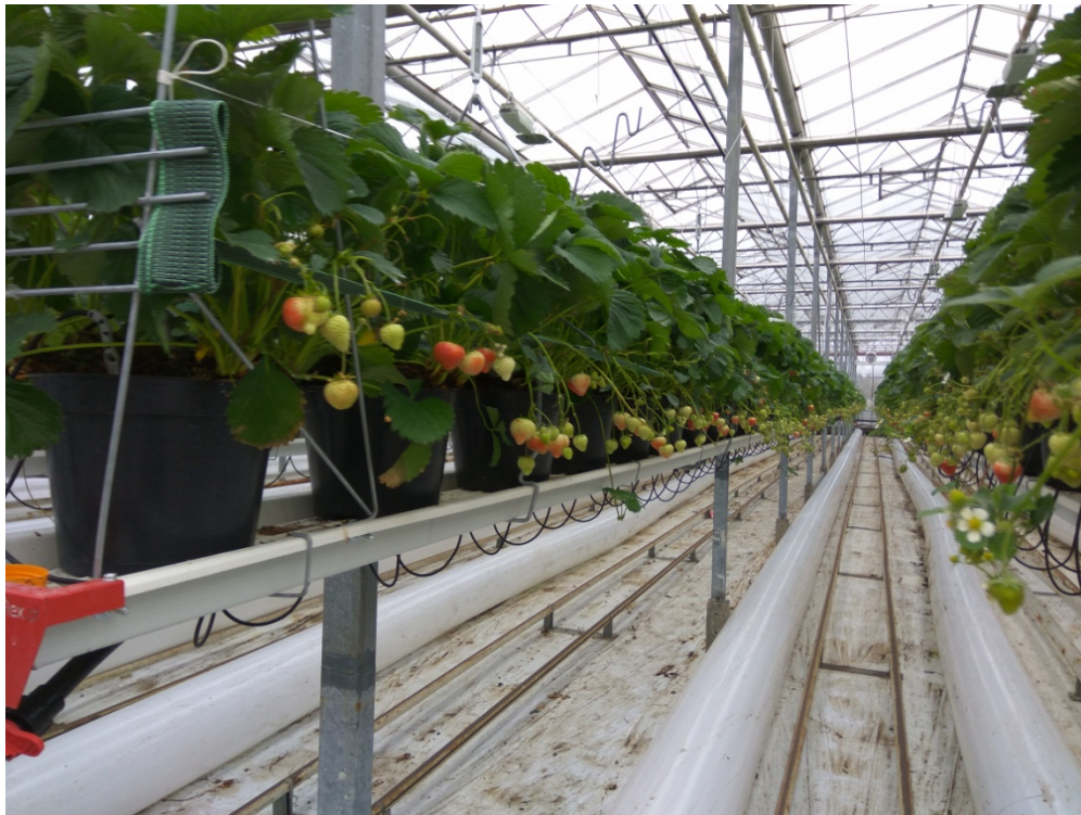
Fot. 1. Częściowy widok nawy z rozmieszczeniem rynien uprawowych i elementów systemu klimatyzacji
